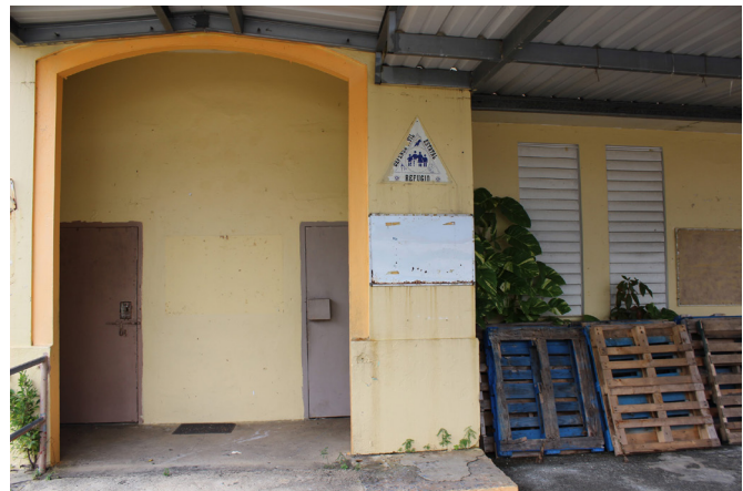
Entrada principal de la escuela Luis Santaella en Aguas Buenas en la que se puede apreciar un letrero comunicando que el plantel está designado como refugio de la Defensa Civil.
