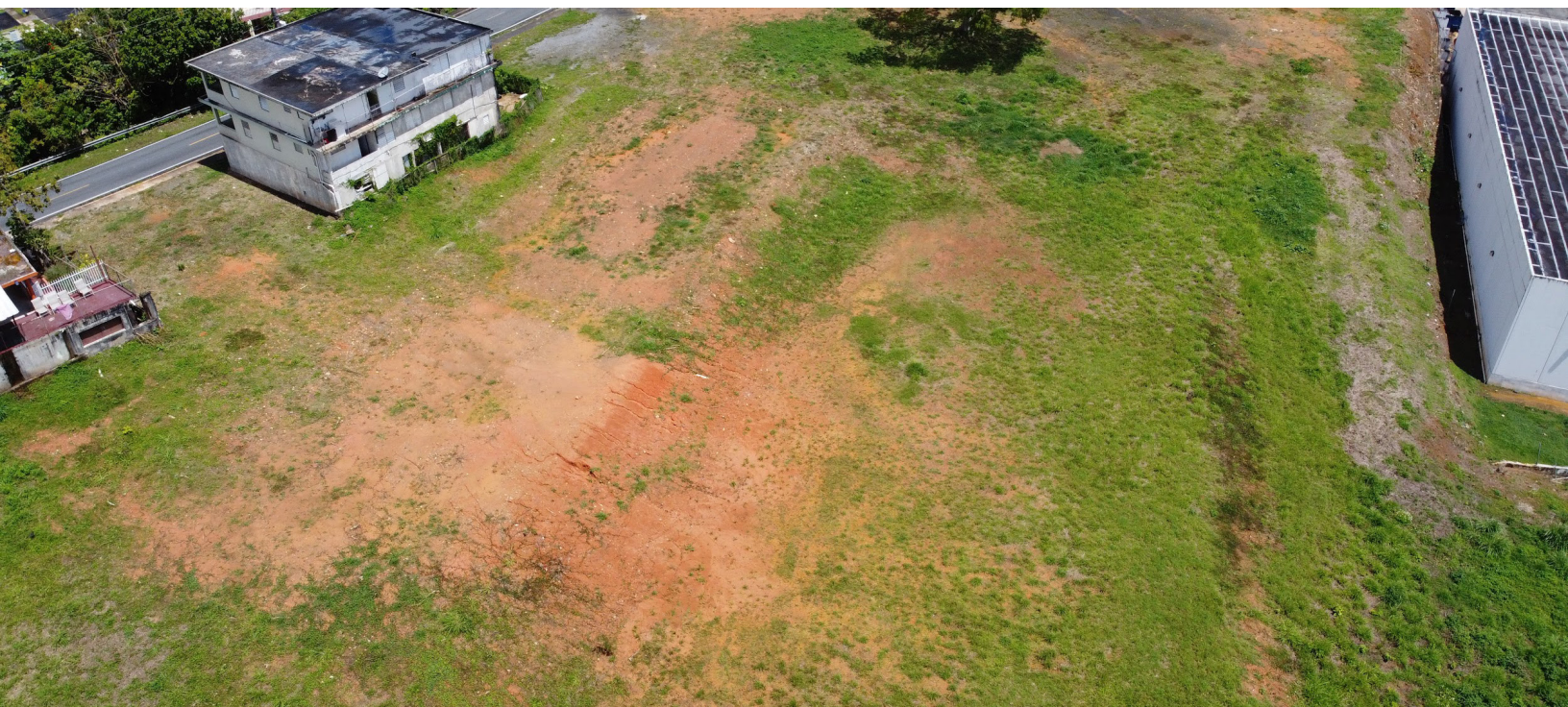
ABAJO La escuela Luis T. Baliñas en Aguas Buenas fue demolida y vendida a un desarrollador privado.
